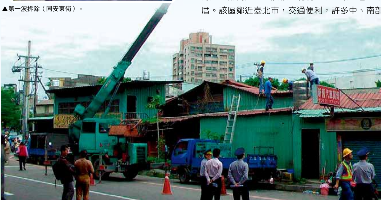
▲第二波拆除（環河南路）。
