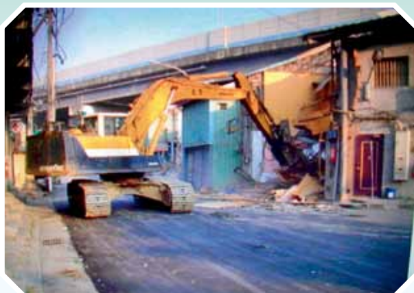
▲第一波拆除（同安東街）。
