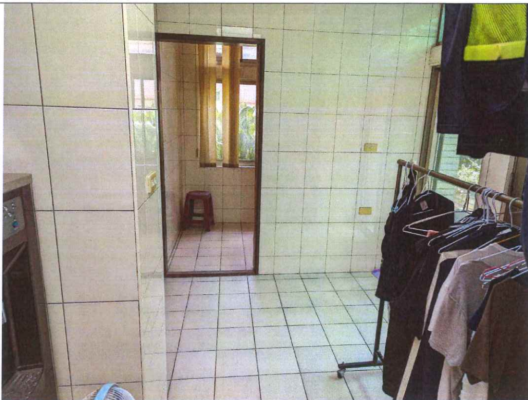
1（性別友善無障礙廁所施工前）
