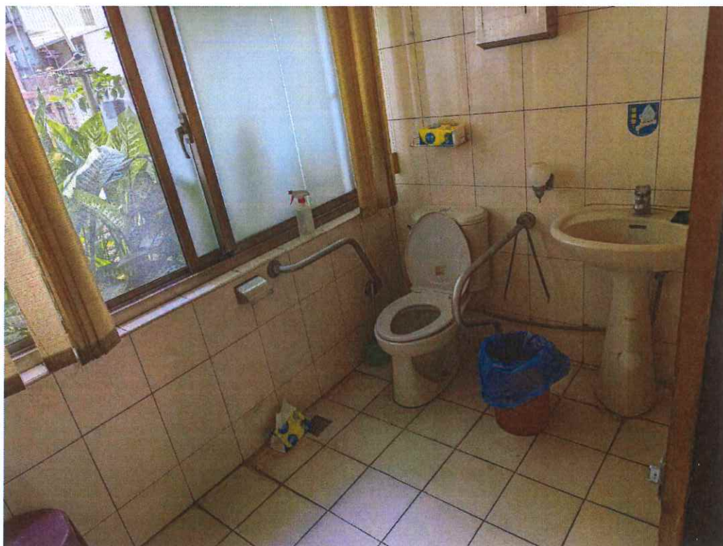
2（性別友善無障礙廁所施工前）
