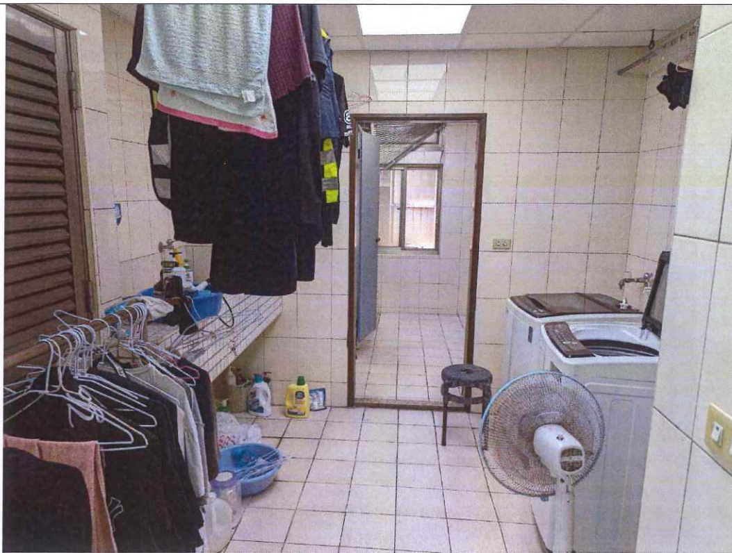
3 (3樓待勤室浴廁施工前)
