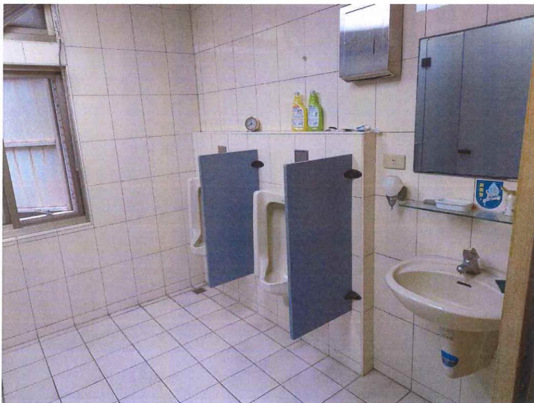
4 (3樓待勤室浴廁施工前)
