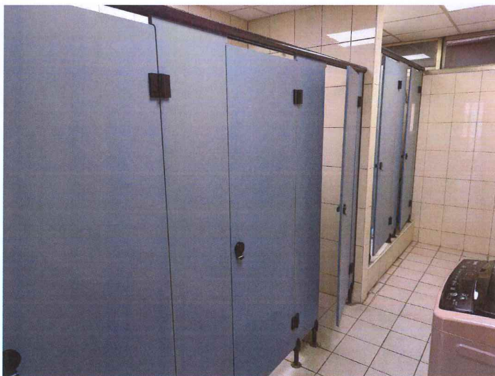
6 (4樓待勤室浴廁施工前)
