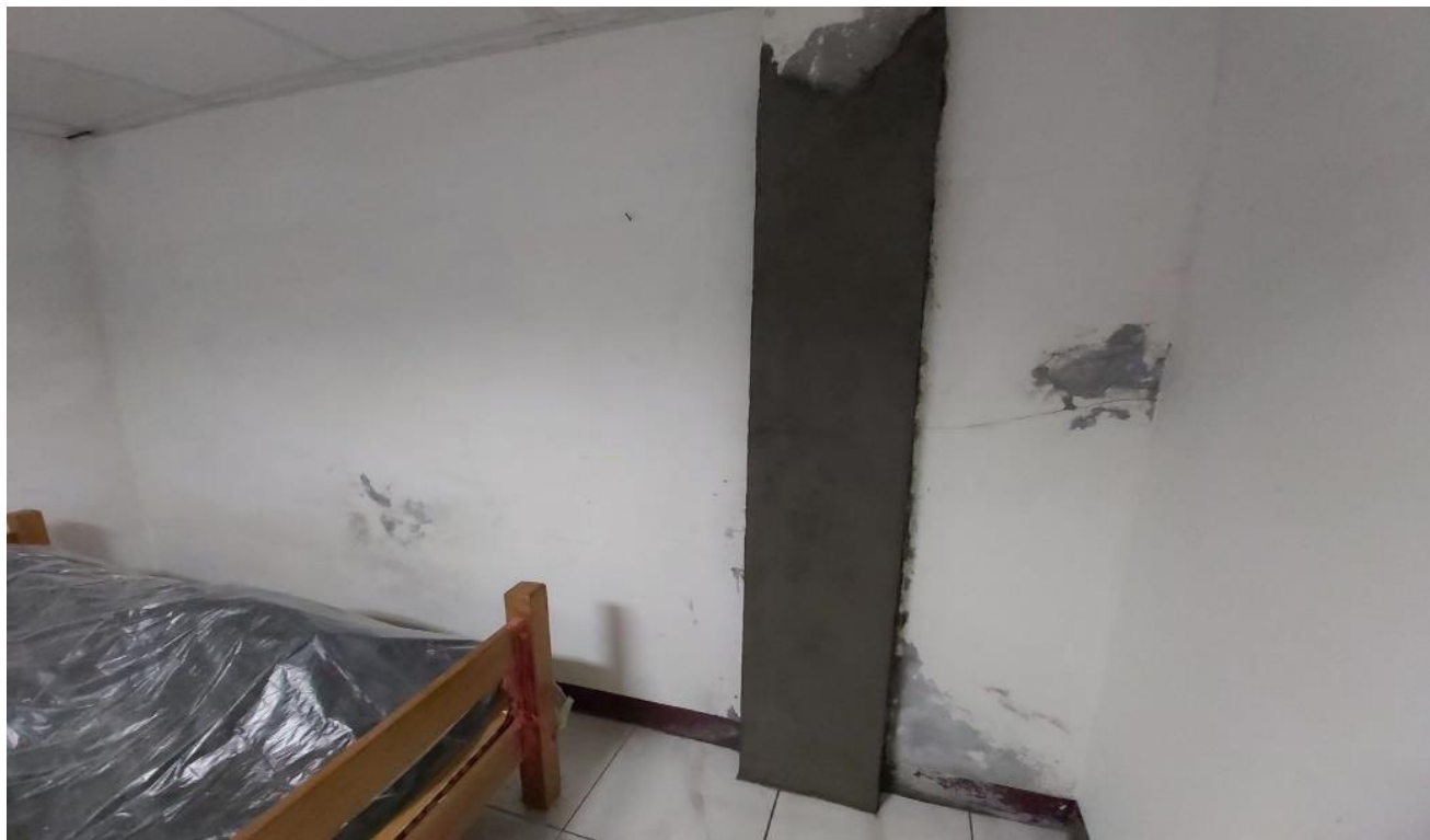
6（德拉楠所施工中）
