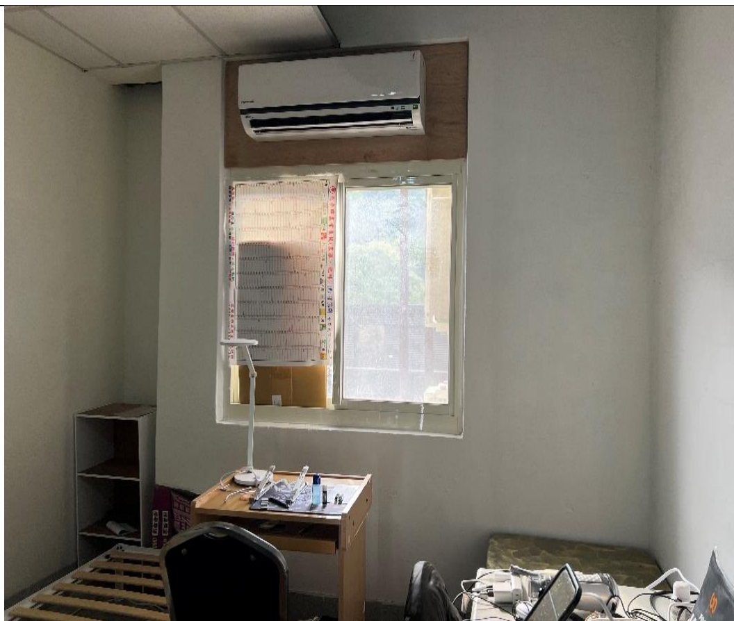
2 (坪林所施工前)
