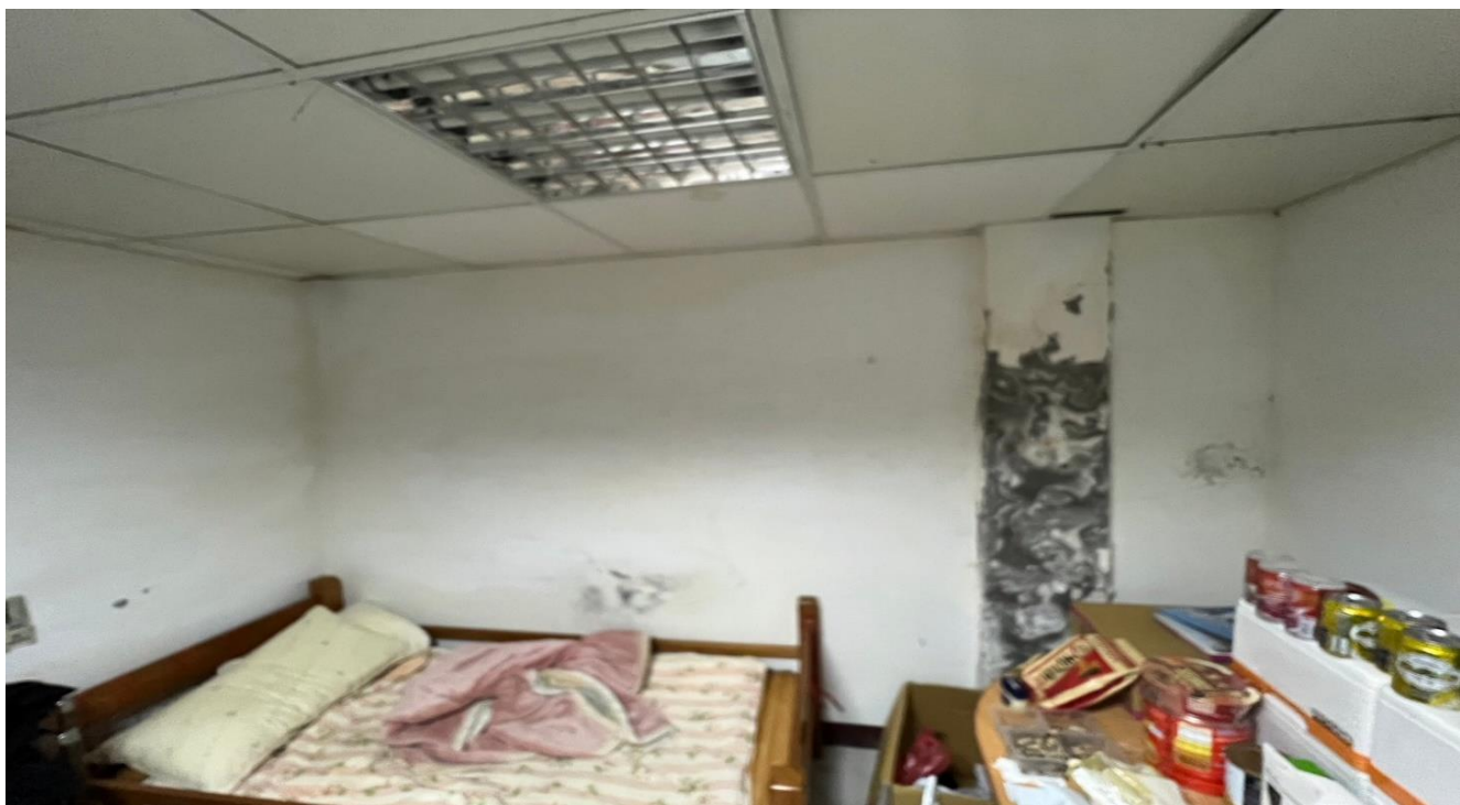
3 (德拉楠所施工中)
