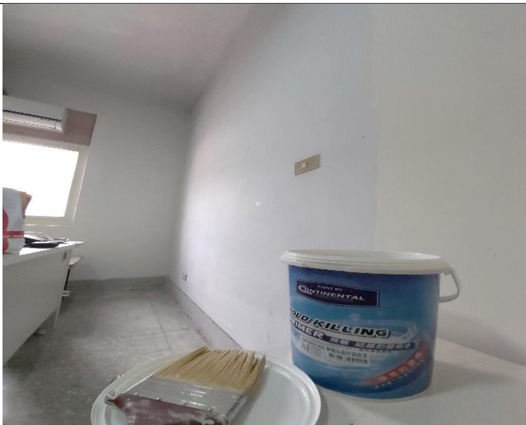
5(坪林所施工中)
