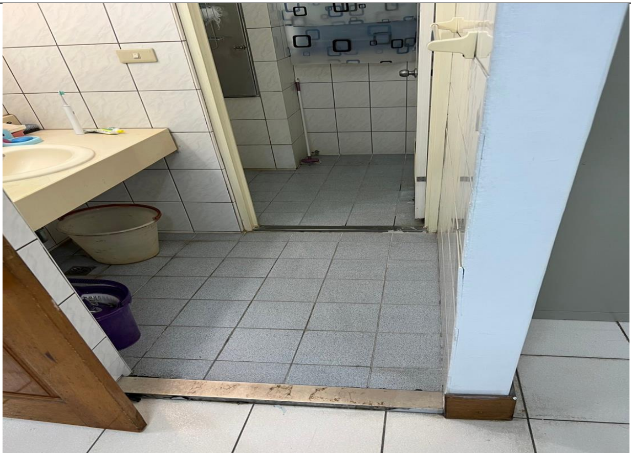
2（雙城所施工前）
