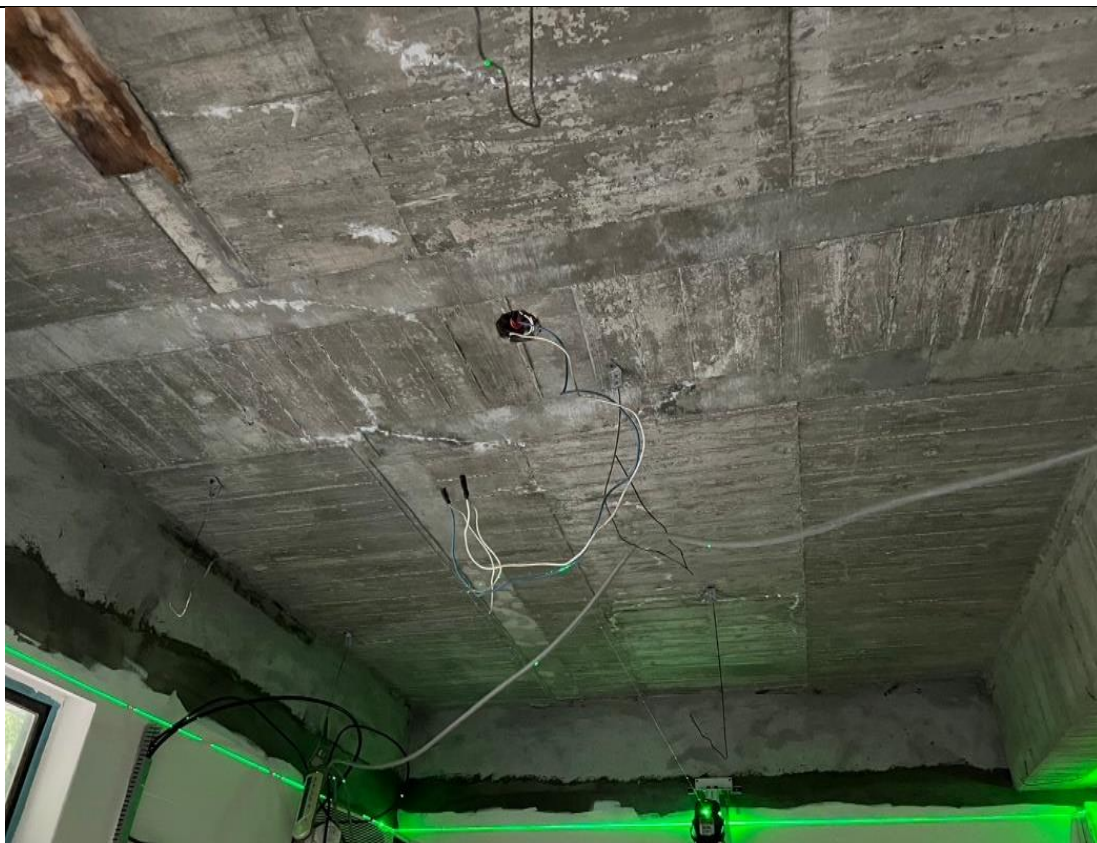
5(哪哮所施工中)
