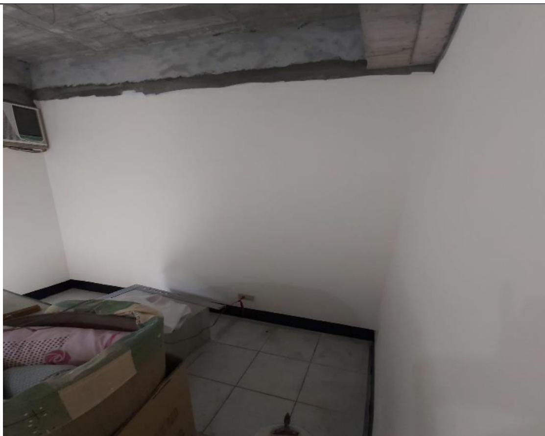
6 (哪哮所施工中)
