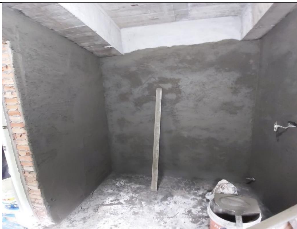
3 (哪嗒所施工中)
