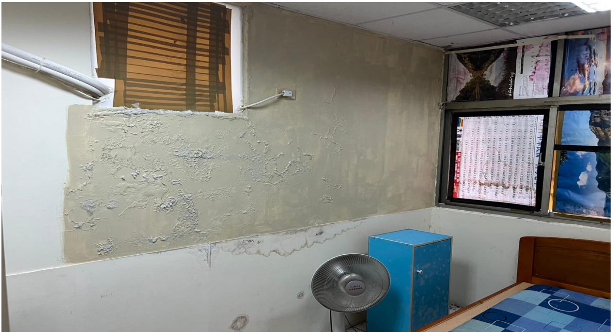
1 (德拉楠所施工前)
