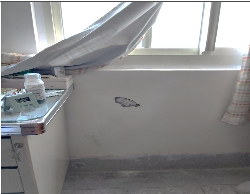
3 (坪林所施工中)
