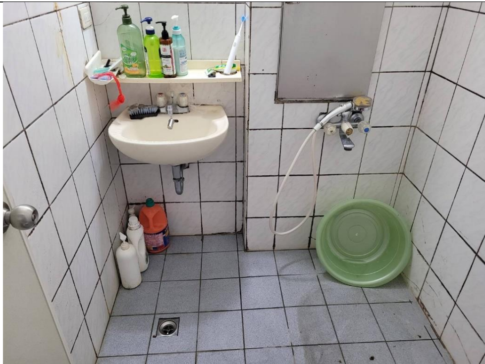
1（雙城所施工前）
