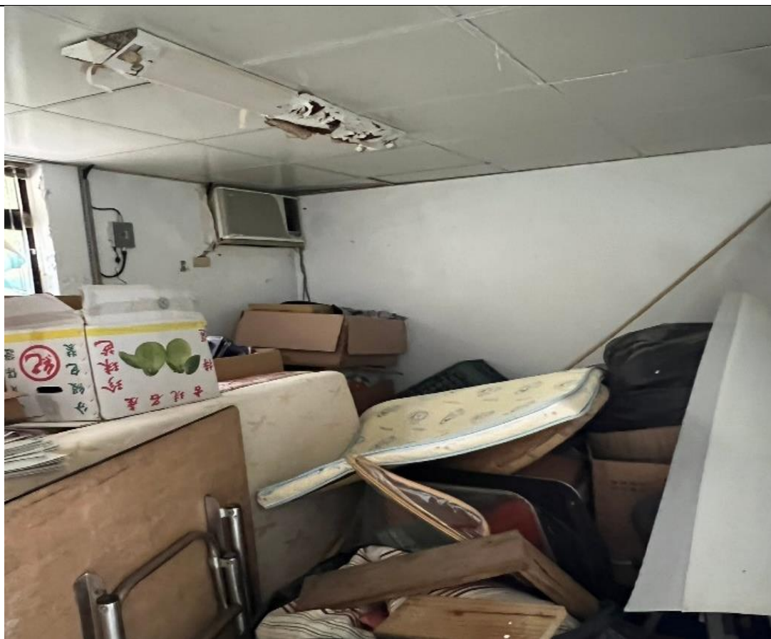
2 (哪嗒所施工前)
