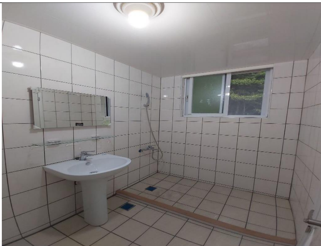
7（哪哮所施工中）
