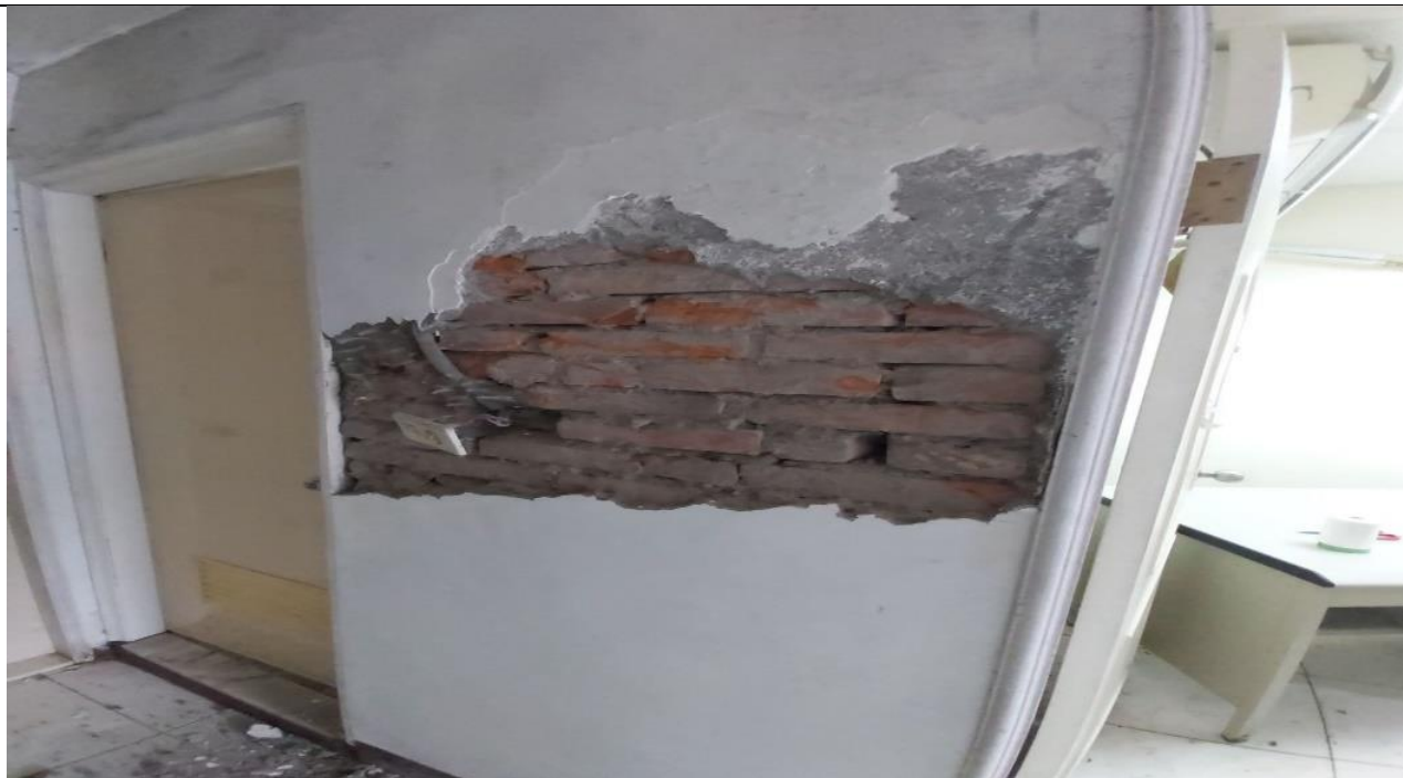
5(德拉楠所施工中)
