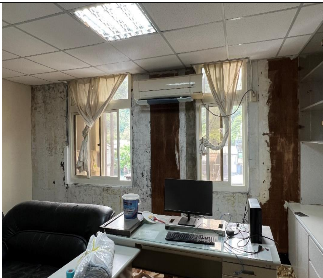
4 (坪林所施工中)
