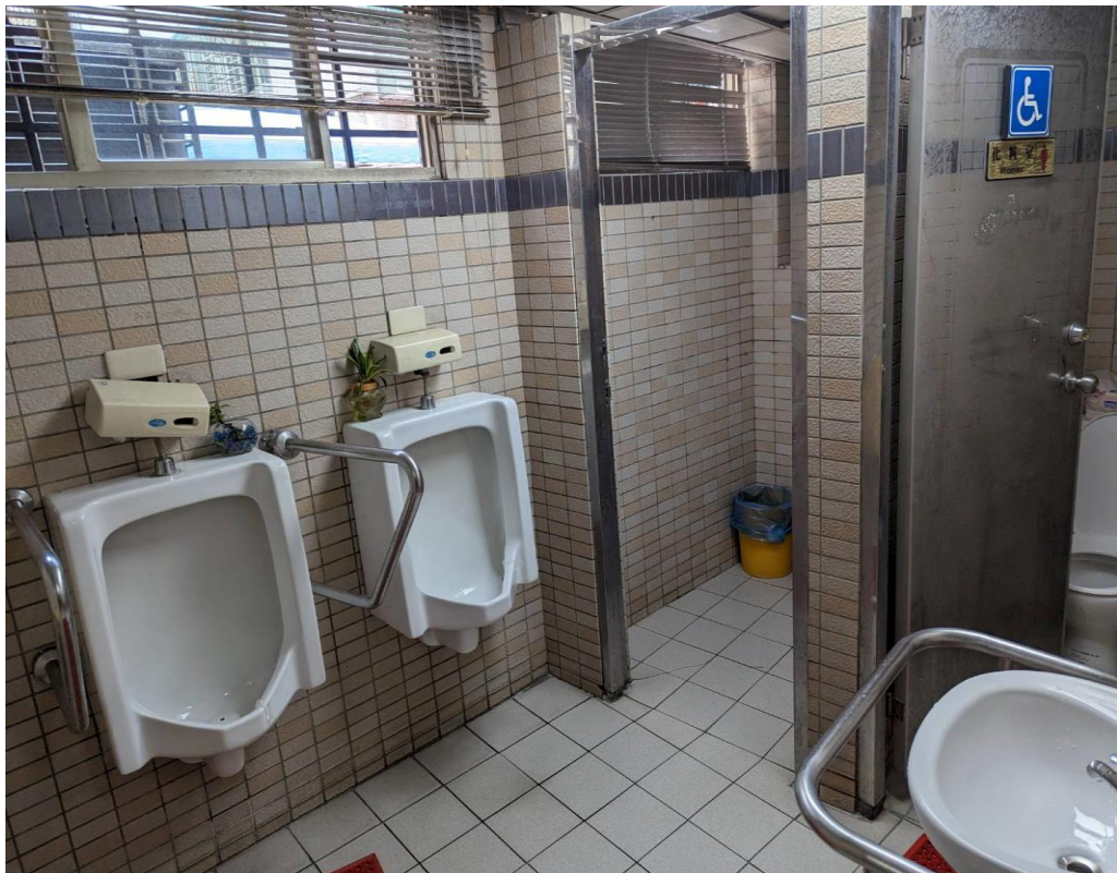
2（1樓廁所施工前）
