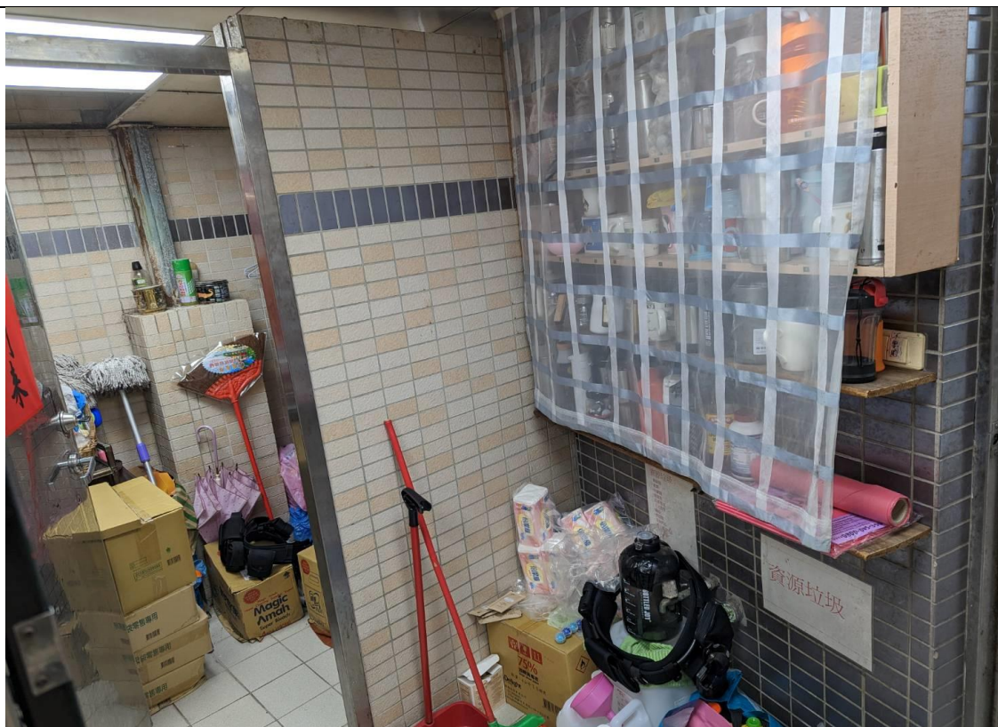
3 (1樓廁所施工前)
