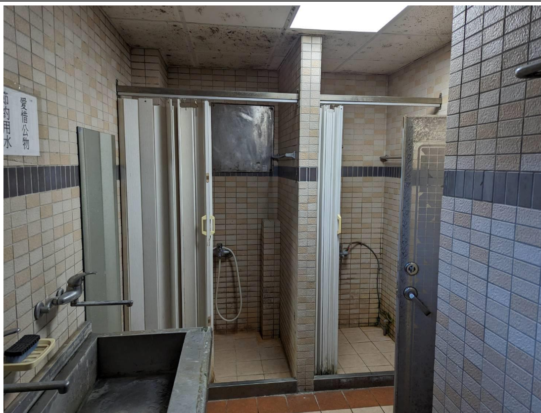
4 (3樓待勤室浴廁施工前)
