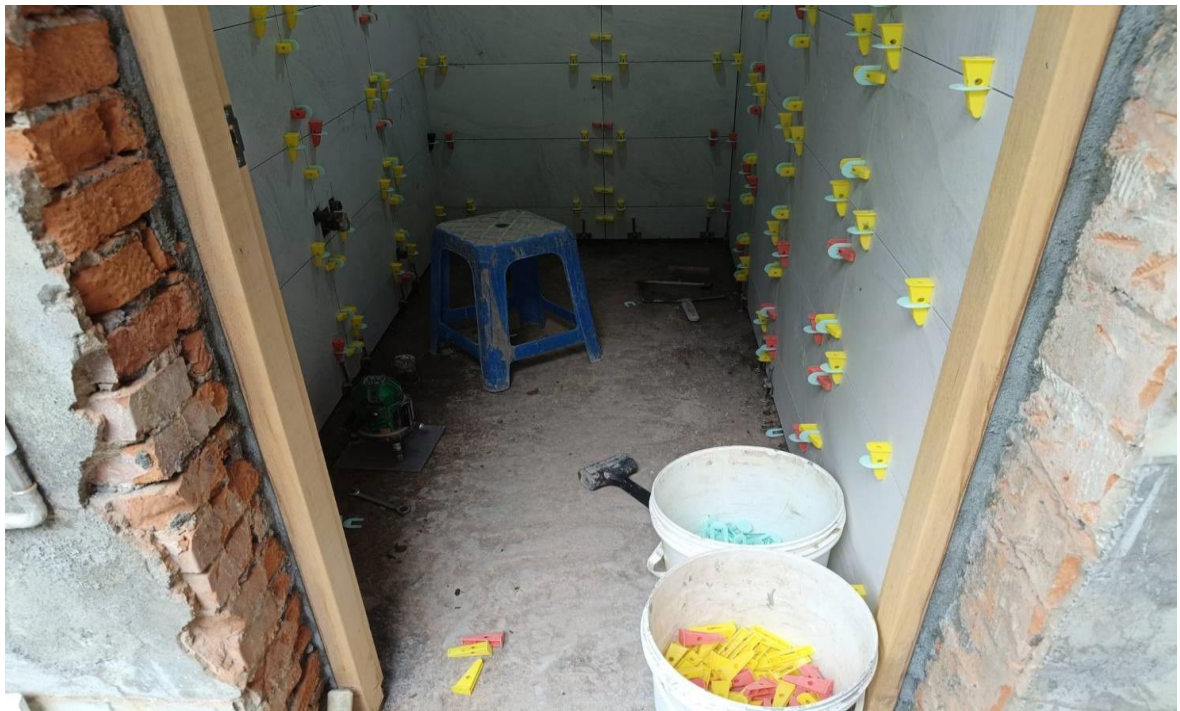
瑞芳分局平林派出所(施工中)
