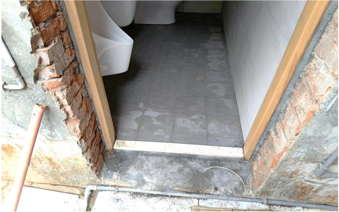
瑞芳分局平林派出所(施工中)
