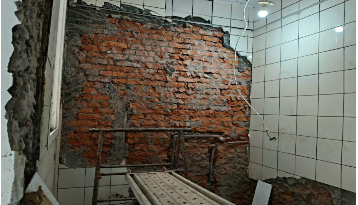
瑞芳分局猴硐派出所(施工中)
