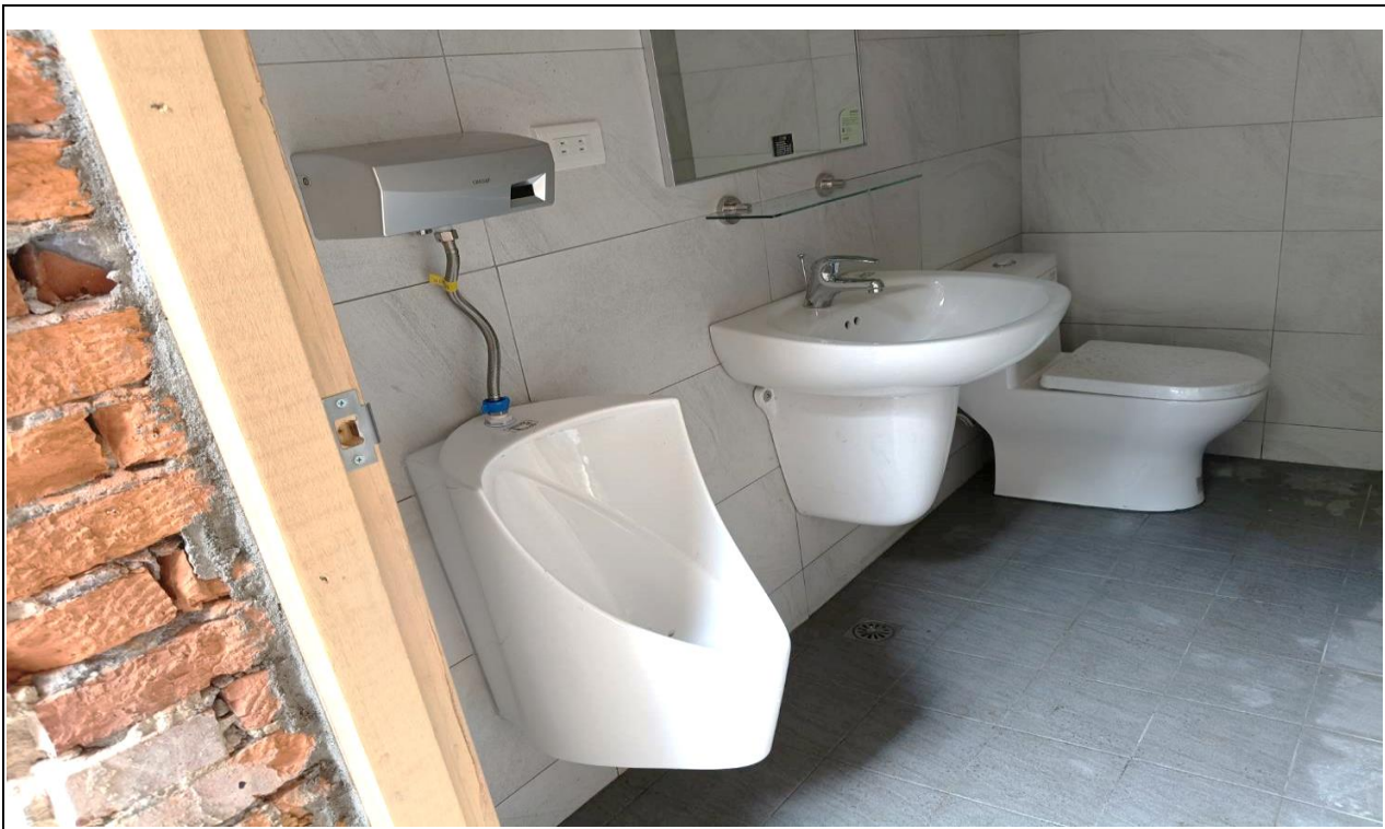
瑞芳分局平林派出所(施工後)
