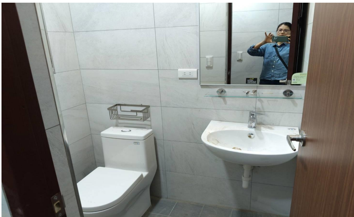
瑞芳分局猴硐派出所(施工後)
