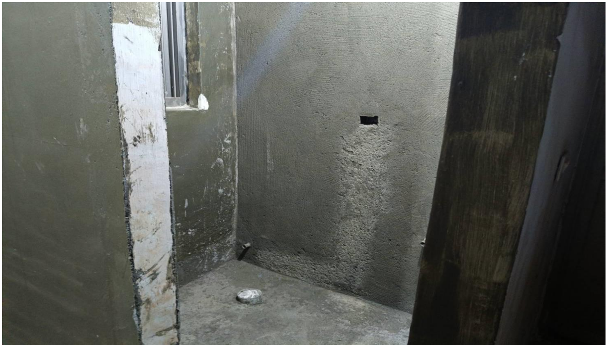
瑞芳分局猴硐派出所(施工中)
