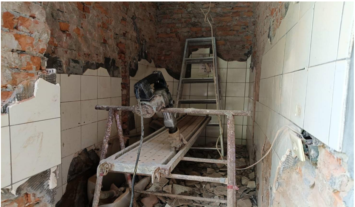
瑞芳分局平林派出所(施工中)
