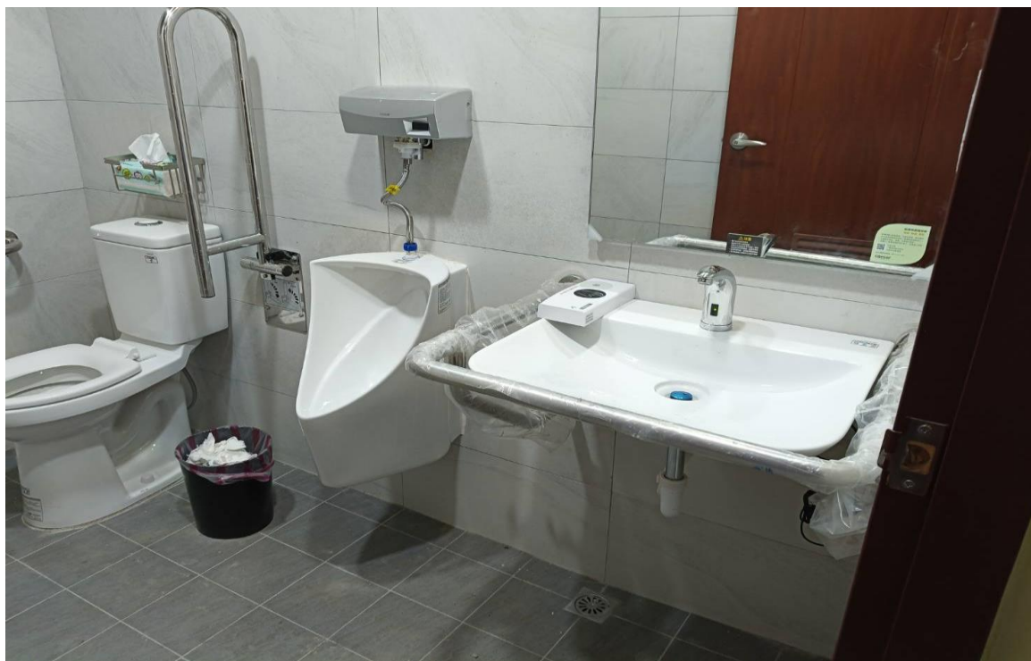
瑞芳分局猴硐派出所(施工後)
