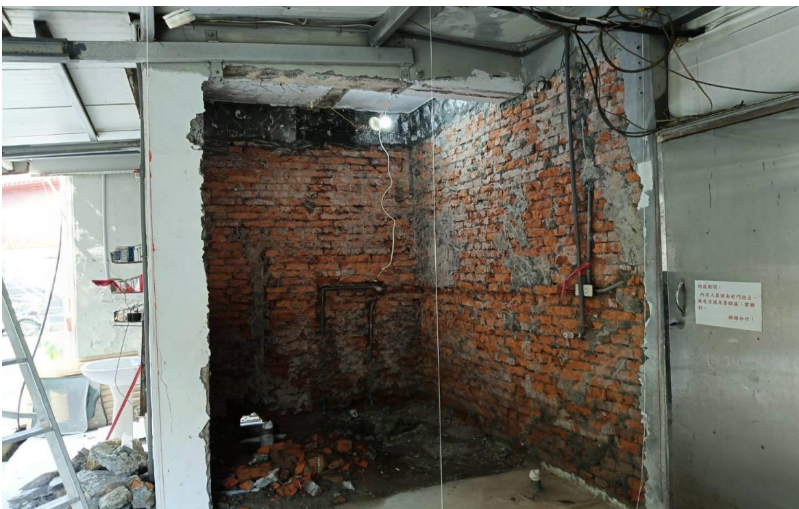
瑞芳分局猴硐派出所(施工中)
