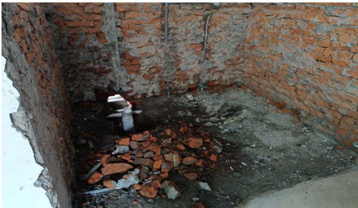
瑞芳分局猴硐派出所(施工中)
