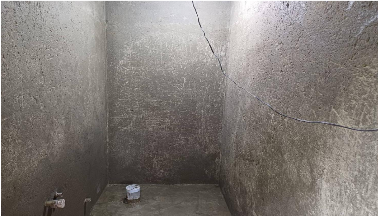
瑞芳分局平林派出所(施工中)
