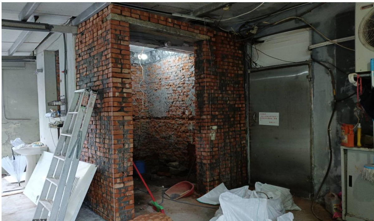
瑞芳分局猴硐派出所(施工中)
