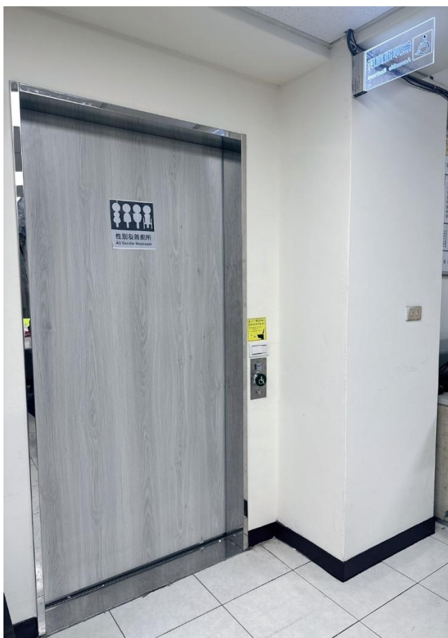
(永和分局新生所改善1樓廁所，性別友善標示)
