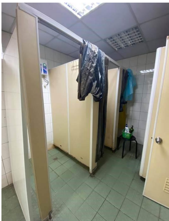
(永和分局新生所改善6樓員警浴廁)整修前
