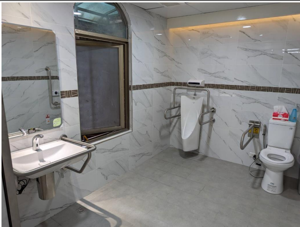
(永和分局新生所改善1樓廁所符合身心障礙者使用兼具性別友善使用)整修後
